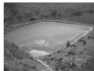
Las entradas de las aguas residuales a las lagunas deben de ser múltiples con caudales equitativos de manera que se eviten cortos circuitos hidráulicos o zonas hidráulicas muertas.
