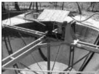
Como parte del tratamiento primario de las aguas residuales, estas deben depositarse en un pozo homogenizador antes de tirar el efluente a la laguna para que los sólidos sean separados de los líquidos.
