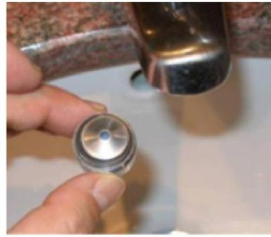
**Figura 5:** Restrictores de caudal de fabricación casera.
