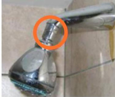
**Figura 1:** Controlador de flujo (arriba); controlador de flujo acoplado a la base de una regadera (centro); controlador de flujo acoplado a la manguera de una ducha teléfono (abajo).
