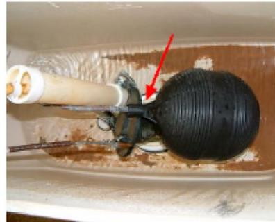
**Figura 4:** Un brazo de flotador mal ajustado puede llegar a apoyarse sobre la válvula de descarga y mantenerla abierta.
