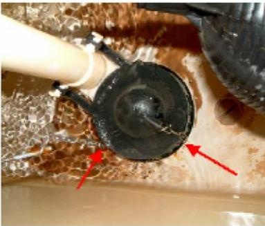
**Figura 3:** Una cadena demasiado larga puede quedar atrapada entre la válvula de descarga y la salida de la cisterna.
