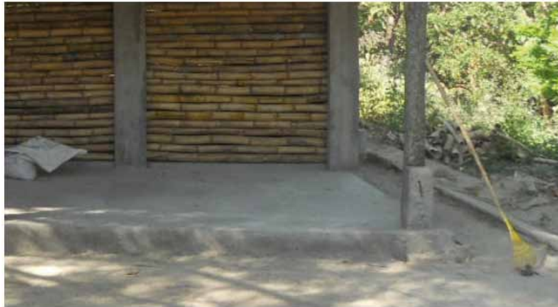
Figura 14. Canaletas Fuente: Granja Avícola en El Salvador
