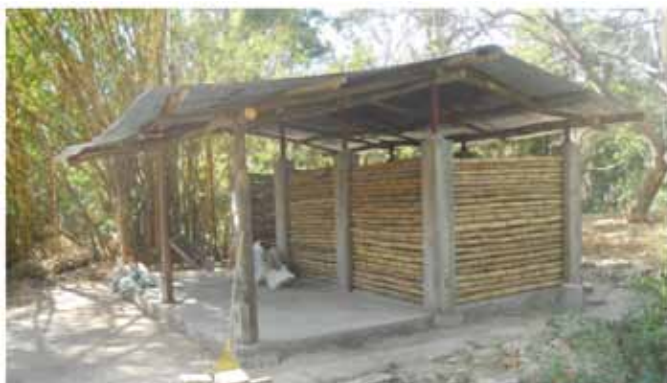
Figura 11. Techo con aleros. Fuente: Granja Avícola en El Salvador
