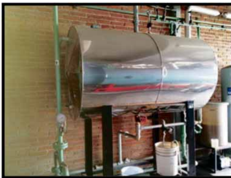
Ilustración 7. Aplicación de aislamiento térmico en tanque caliente
