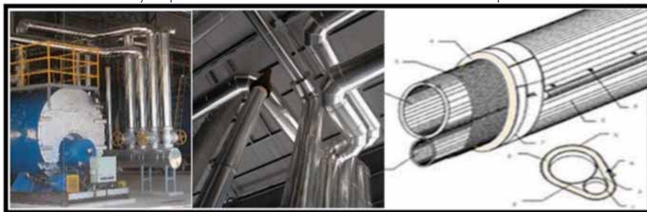
Ilustración 5. Vistas de la protección del aislamiento térmico en tuberías y esquematización del aislamiento térmico en venas de vapor
